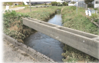
水位の下がった浄土川
