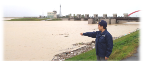
信濃川・大河津分水可動堰付近
