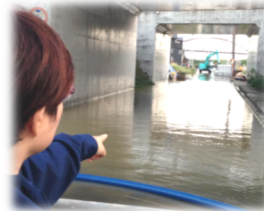
水没したアンダーパス
